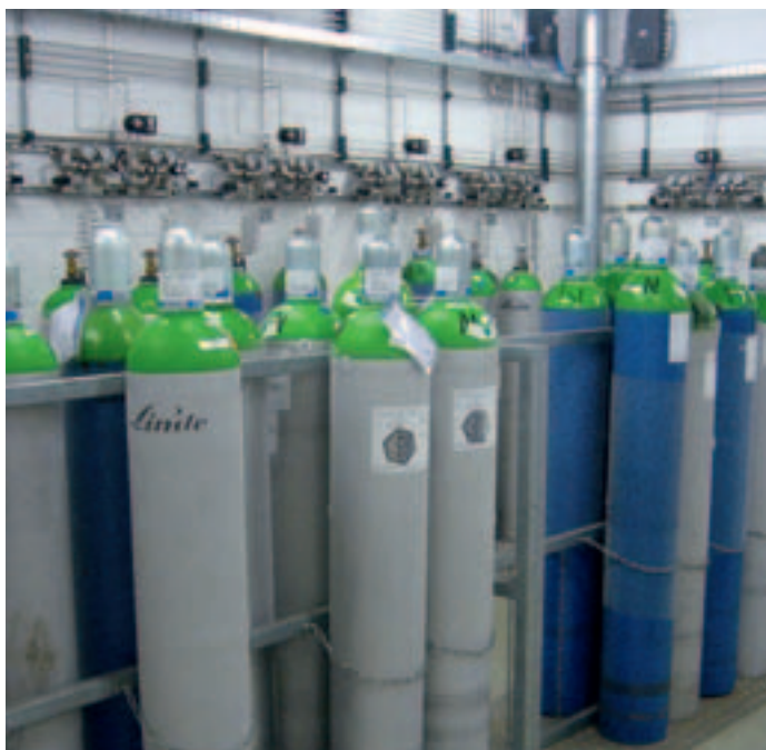
Zentrale Gaseversorgung von Prüf- und Reingasen für die Abgasanalytik in Motorprüfständen inkl. SECCURA® Cylinder Management
